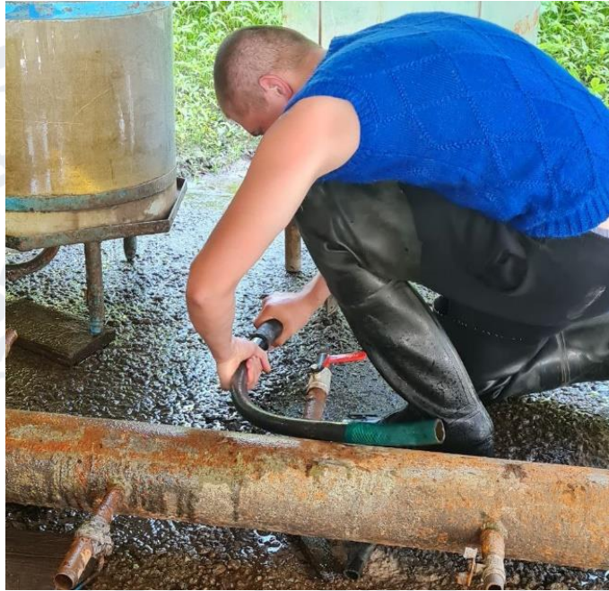
Рис. 23. Заміна труб до водостоку
